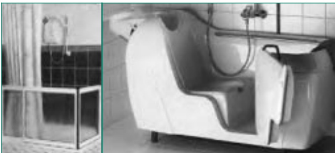
Eine bodenbündige Dusche oder ein Badecoupé sind sinnvolle Hilfen zur Erleichterung der täglichen Körperpflege.
